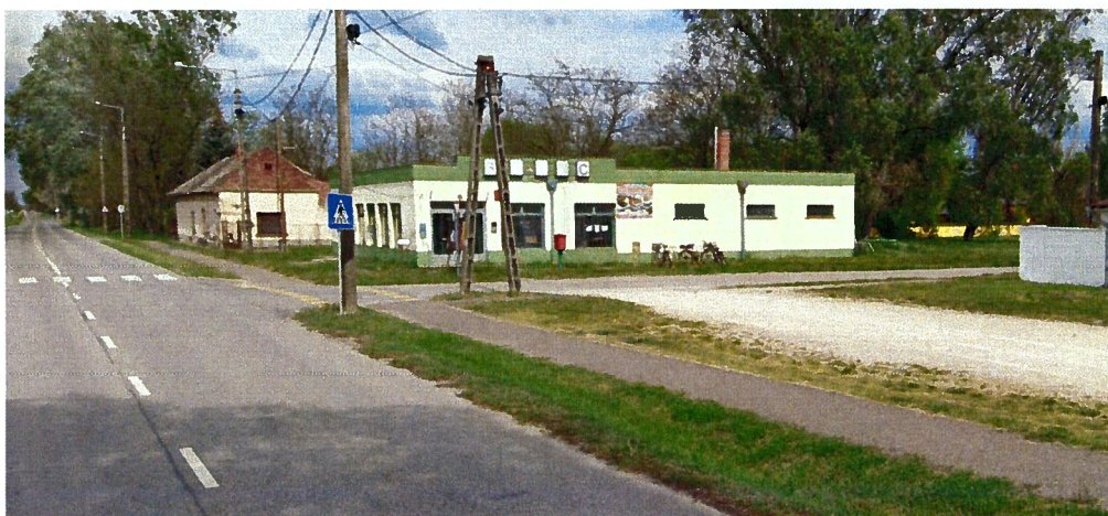
A felújítani tervezett épület
