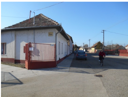
A Bajcsy utcai bontandó épületek
