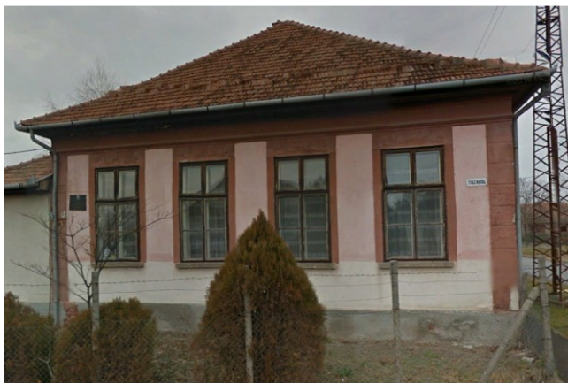
Tiszabögi iskola (óvoda)
